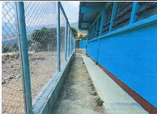
Foto 1: FINALIZACIÓN DE CERRAMIENTO PERIMETRAL EN SU TOTALIDAD.
