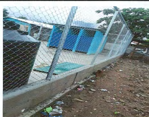
Foto 2: FINALIZACIÓN DE CERRAMIENTO PERIMETRAL
